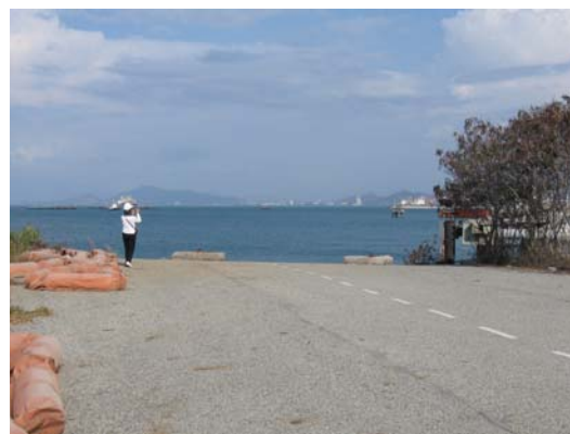
สะพานทอดเทียบเรือ (Ro – Ro Ramp)
