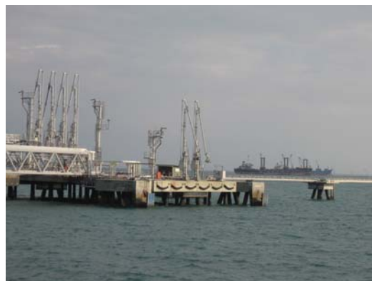
ท่าเทียบเรือและอุปกรณ์บรรทุกขนถ่ายน้ำมัน
